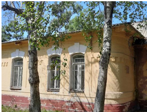
Здание детского сектора. Блюхера, 15 А
